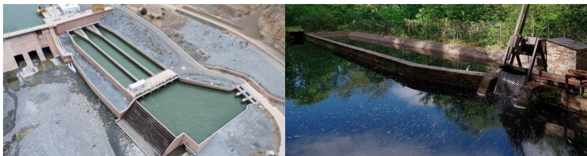
Figura 8-10. Ejemplo de Desarenadores
