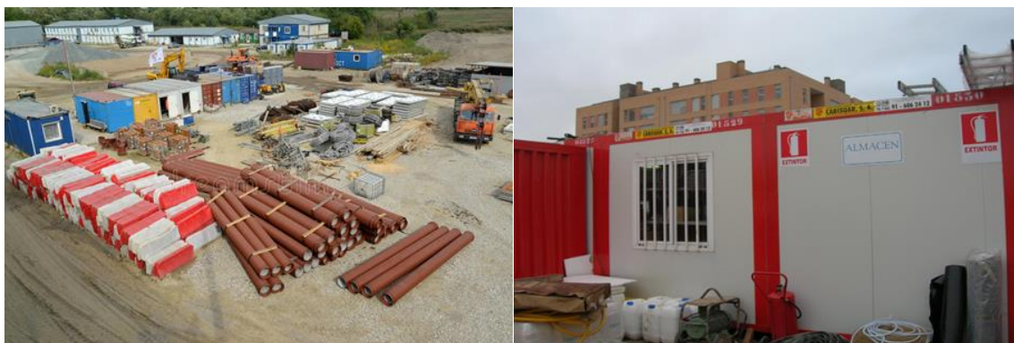
Figura 8-32. Ejemplo de Área de Taller y Acopio de Materiales
