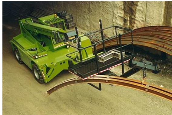
Figura 8-39. Ejemplo de Plataforma Hidráulica para Colocación de Marcos Metálicos
