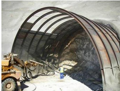
Figura 8-40. Ejemplo de Protección del Portal Instalado
