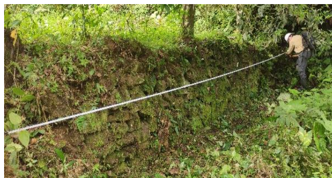
Figura 7-149. Muros de roca sector El Rosario
