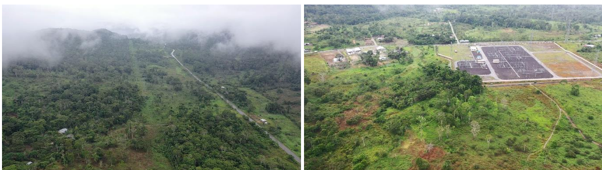
Figura 9-5. Área de Llegada de la Línea de Transmisión a la Subestación Bomboiza
