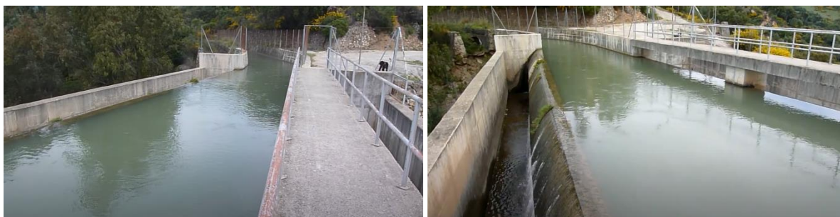
Figura 8-18. Ejemplos de Cámara de Carga
