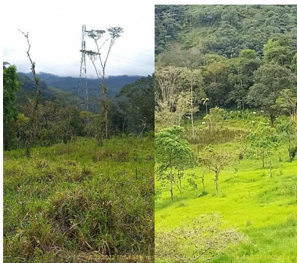
Figura 7-20. Área de implantación del proyecto (línea de transmisión)
