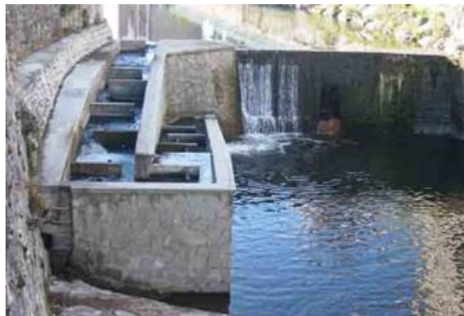
Figura 8-7. Ejemplo de Escalera de Peces
