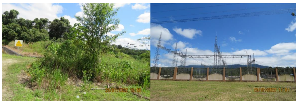
Figura 7-24. Área de implantación del proyecto (línea de transmisión)
