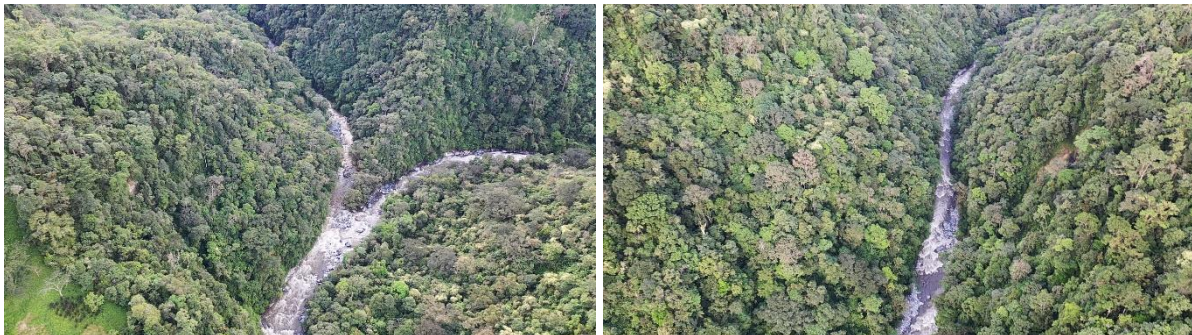
Figura 9-8. Áreas de Casa de Máquinas 1 y Casa de Máquinas 2
